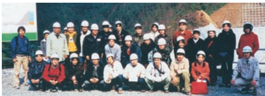
山口県大津郡油谷町に建設中の阿惚ダムの工事現場で(後列左から3番目が筆者)
